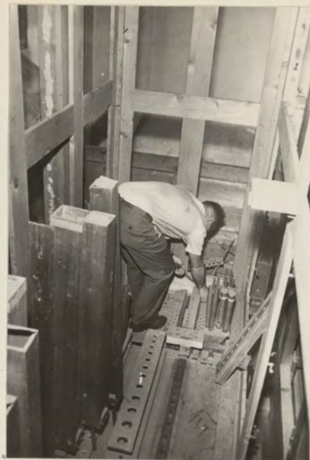
B 20 Blick in den Schwellkasten. Die Diskantlade wird abgeräumt!
