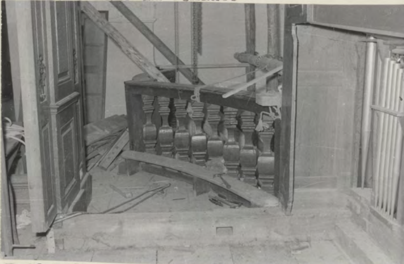
F 22 Balken, auf dem die R.P. Lade durch horizontale Träger liegt, sie liegt nicht auf diesem Balken selbst!
