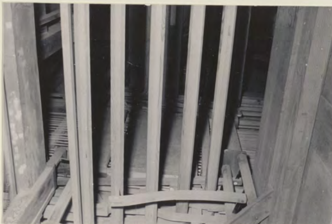
G 8, Stangen der Registertraktur, beidseits der ursprünglichen Spielschranknische
