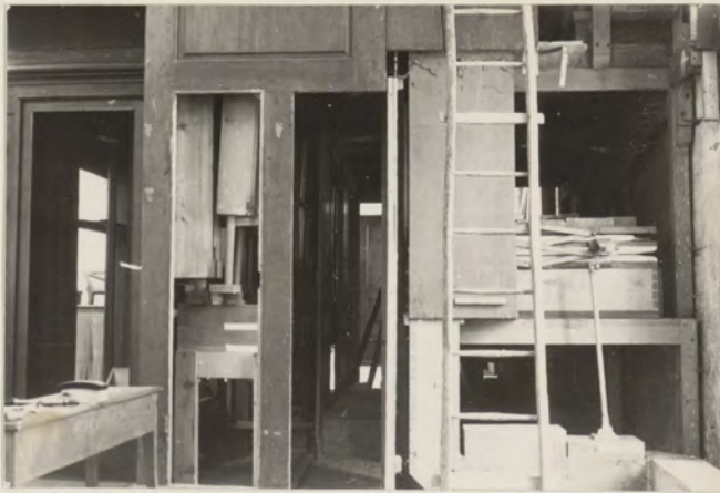
A 3 Cs-Lade Silbermanns im geöffneten Gehäuse (links 16', rechts 8', Trompete nicht sichtbar)
