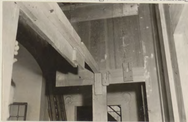
E 15 Halter für Rasterstangen, links Octavbass 8', rechts 16'
